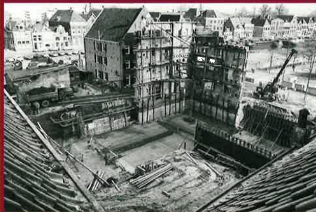
conservatoriumvleugels in aanbouw. De gevels van de voormalige 'Flesseman' bleven staan
