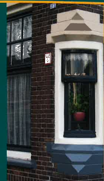
door dit raam zal geen reder meer uitkijken over de Thorbeckegracht
